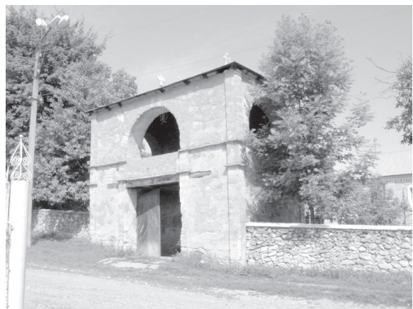
Fig. 6. Clopotnița bisericii Schimbarea la față a Domnului.
