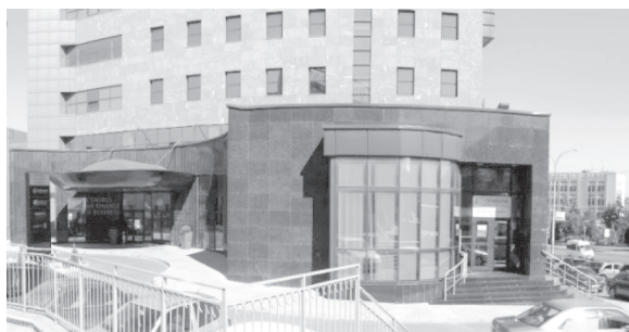
Fig. 2. „Accent Business Park” (sediul „Eximbank”), partea stereobatică, vedere dinspre „ARTICO”
