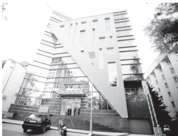
Fig. 8. Centrul internațional de afaceri „Le ROI”, vedere dinspre str. C. Lazo.
