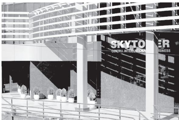
Fig. 5. „SKYTOWER”, vedere din curtea interioară.
