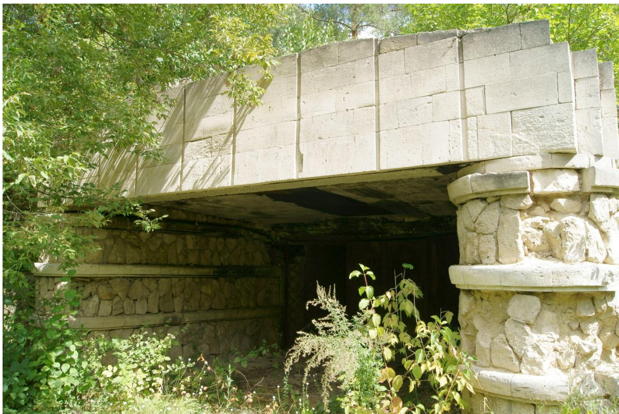
Figura A3.83. Intrare abandonată în galeriile subterane (spațiu de degustare). Arhitect R. Kurt
