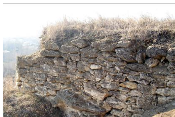
Figura A3.5. Structura zidăriei pereților de sprijin (foto A. Dimitrov, 2012)
