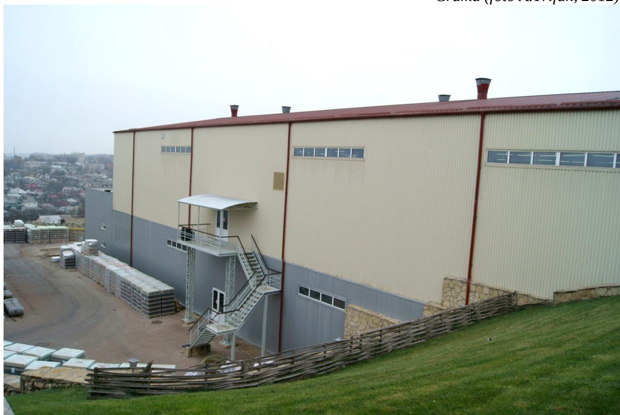
Figura A4.62. Vedere spre cramă din partea restaurantului
