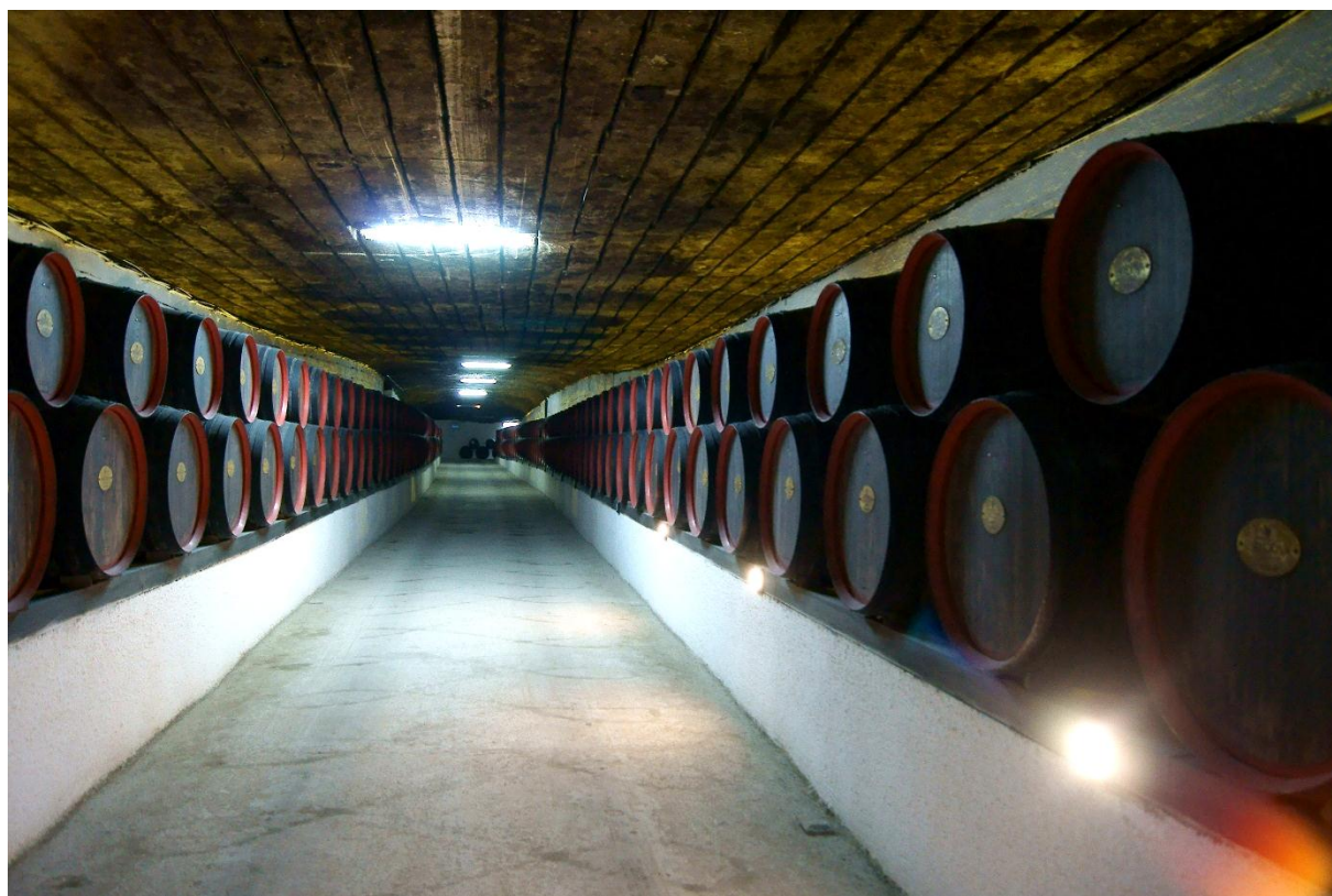
Figura A3.45. Galeria pentru depozitarea vinurilor în butoaie (foto V. Trifan, 2018)
