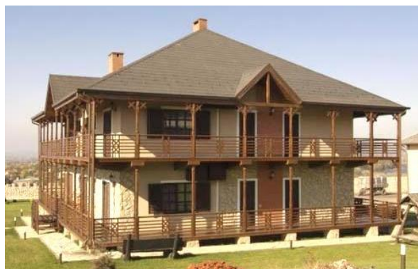
Figura A4.73. Vila Nord. Fațadă
